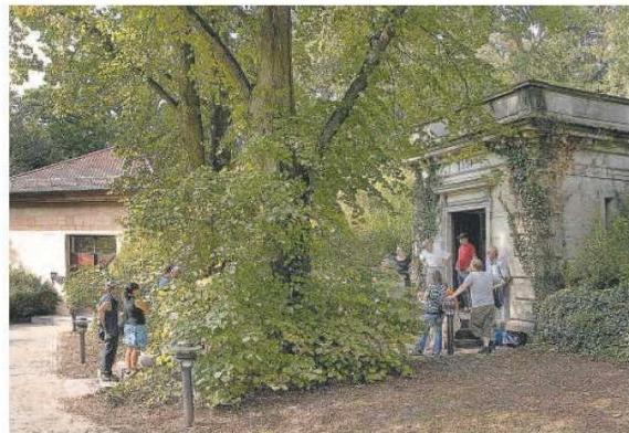
Auf dem Burgberg stand neben dem imposanten Wasserturm auch das historische (r.) und heutige moderne Wasser-Hochreservoir (l.) zur Besichtigung offen.
